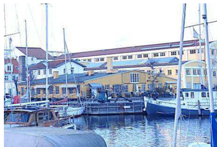
Eksisterende bygning Wilders Plads 11, set fra syd. Bygningen nedrives.
