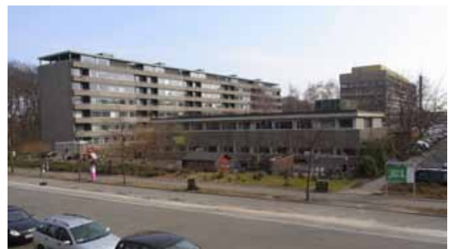
Hospitalets børnehave ved Edel Sauntes Allé samt boligblokken forventes nedrevet for at give plads til parkeringshus, sterilcentral og godsterminal.
