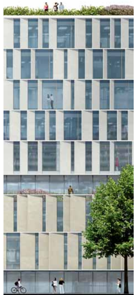
Skitse af facadeudsnit på Nordfløjen med tilbagetrukket åben glasfacade i stueetagen. Herover en tungere og mere lukket Base, og derpå en let og åben etage med glasfacade og øverst en Overbygning i et lettere og mere åbent udtryk end basen. På taget er vist beplantning og opholdsmuligheder. Basen forventes anvendt til patientbehandling og overbygningen fortrinsvis til sengestuer. Illustrationer fra rådgiverteamet.
