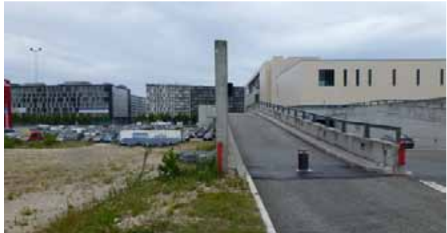
Ove Arups Vej med nedkørsel til p-kælder og rampe til Centergade langs Field's. Område II ligger til venstre for rampen.
