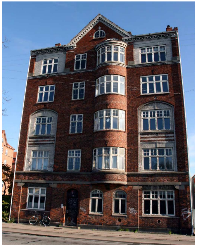
Bevaringsværdig bygning - Sundholmsvej 57
