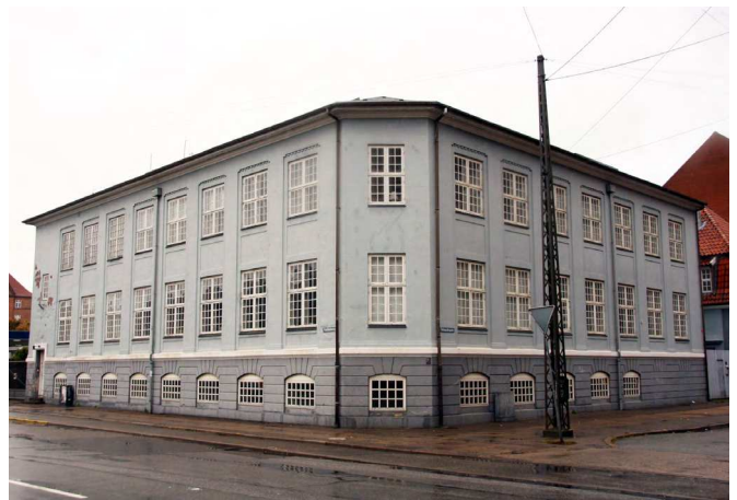
Bevaringsværdig bygning - Sundholmsvej 67-69
