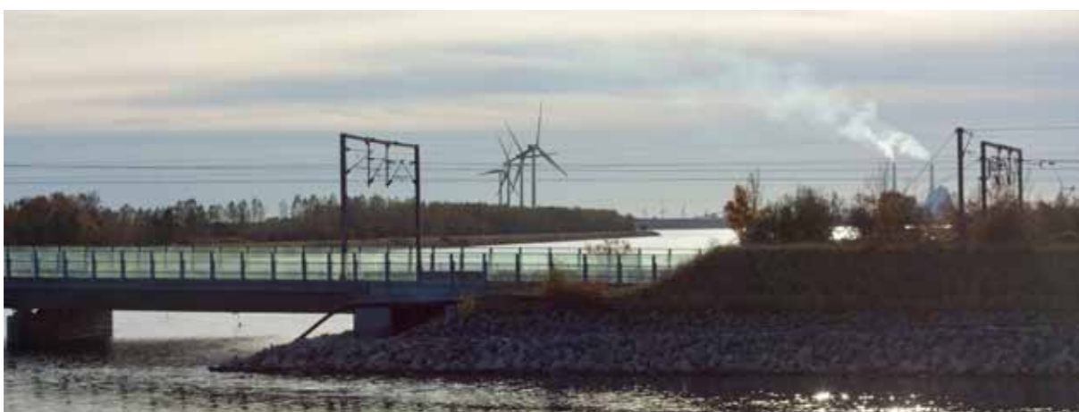
Figur 9.10c Visualisering fra Sjællandsbroen med 120 m vindmøller på en linje langs med diget (forslag B).
