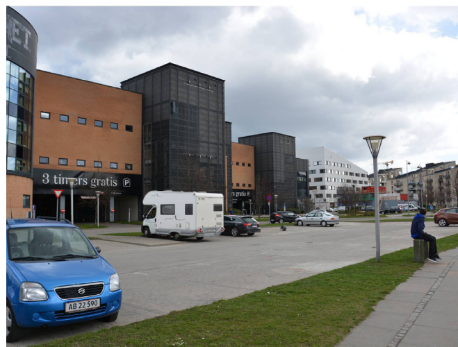
Fisketorvets nuværende facade mod sydvest fremstår i dag uden udadvendte funktioner og er ikke 'bymæssig'.
