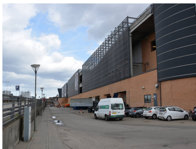
Fisketorvets nuværende facade mod Kalvebod Brygge med vareindleveringsområdet.
