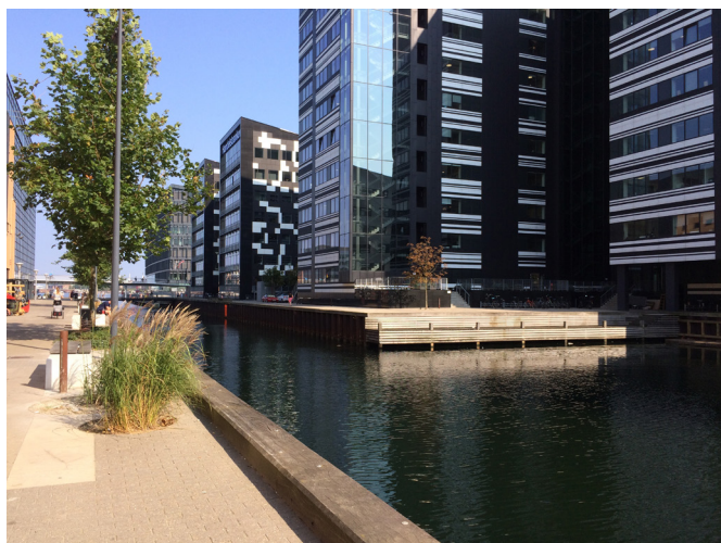
Havneholmen set fra Fisketorvets promenade med kontordomiciler i op til 46 m højde og kanalen, der går fra Gasværkshavnen til Tømmergraven.
