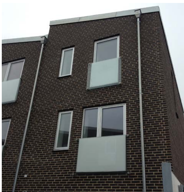
Figur 1: Glasafskærmning foran opdelt fransk altandør med indbygget absorbent.
