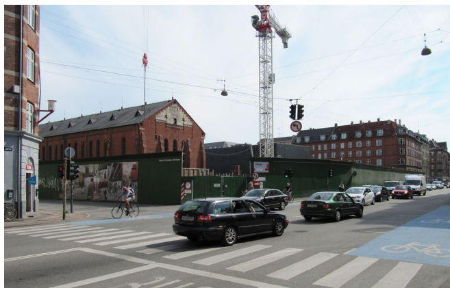
Nuuks Plads ved krydset Jagtvej Rantzausgade, hvor den fremtidige metrostation forventes åbnet juli 2019.
