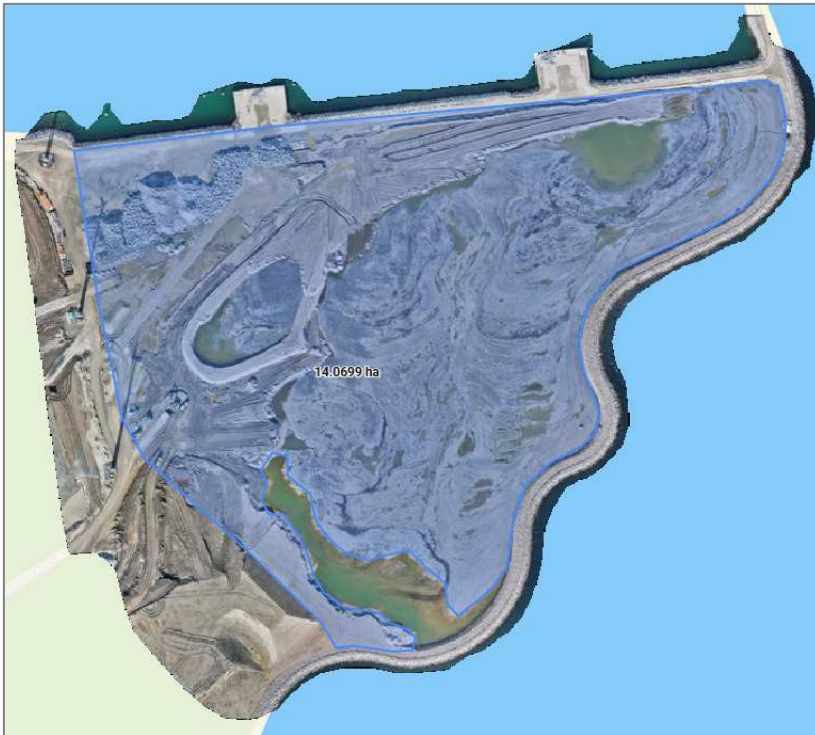
Figur 7. Dronefoto fra januar 2026 af fase 1, bassin A – 14,1 ha er opfyldt til over kote 0 DVR.
