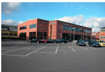
Fitnesscentret Equinox er indrettet i en nyligt ombygget industribygning, hvor de røde teglsten og rødmalede lodrette og vandrette jernbånd er bevaret. De nye store vinduespartier er indpasset i den oprindelige opdeling af facaden.
