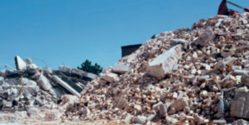
MINDRE NEDRIVNING - Mængden af byggeaffald er faldet i forhold til 1999
