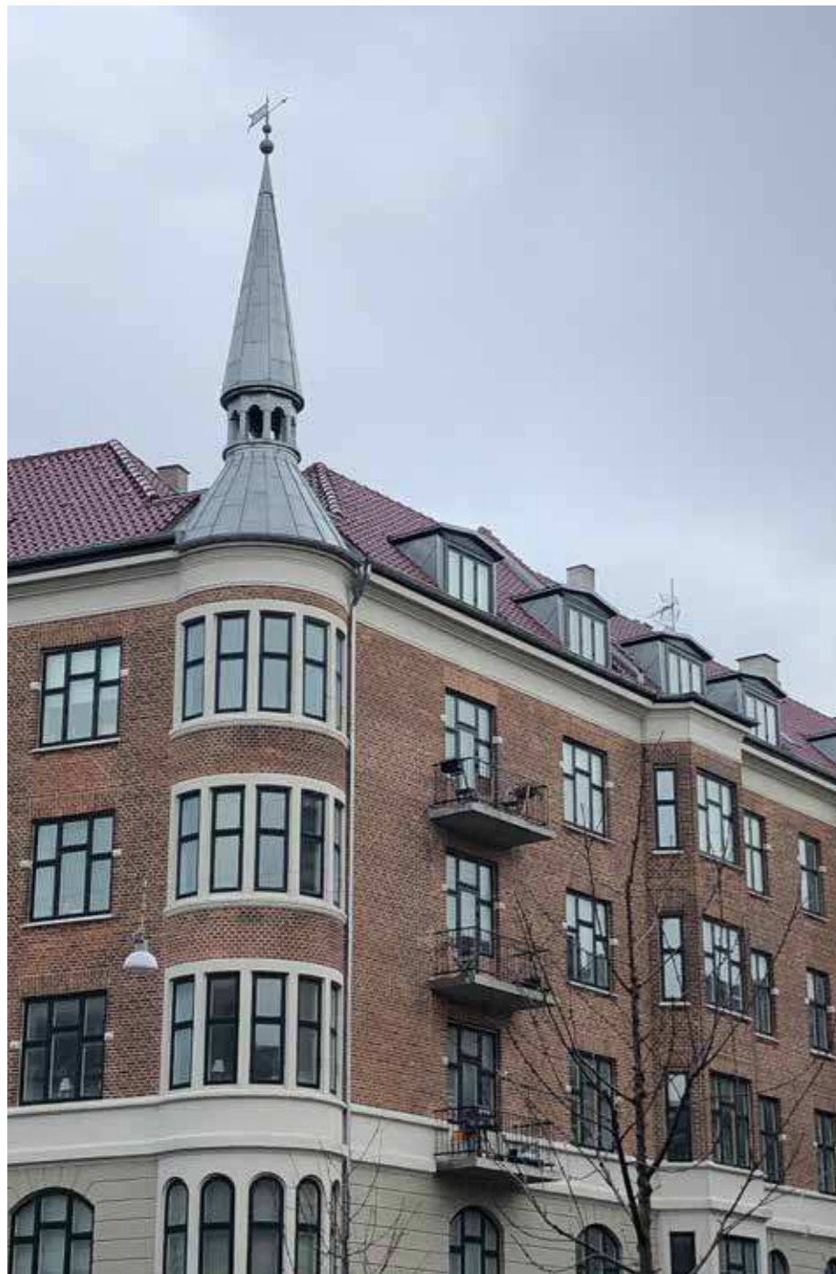
Vellykket tagrenovering på hjørnebygning med tårn.
