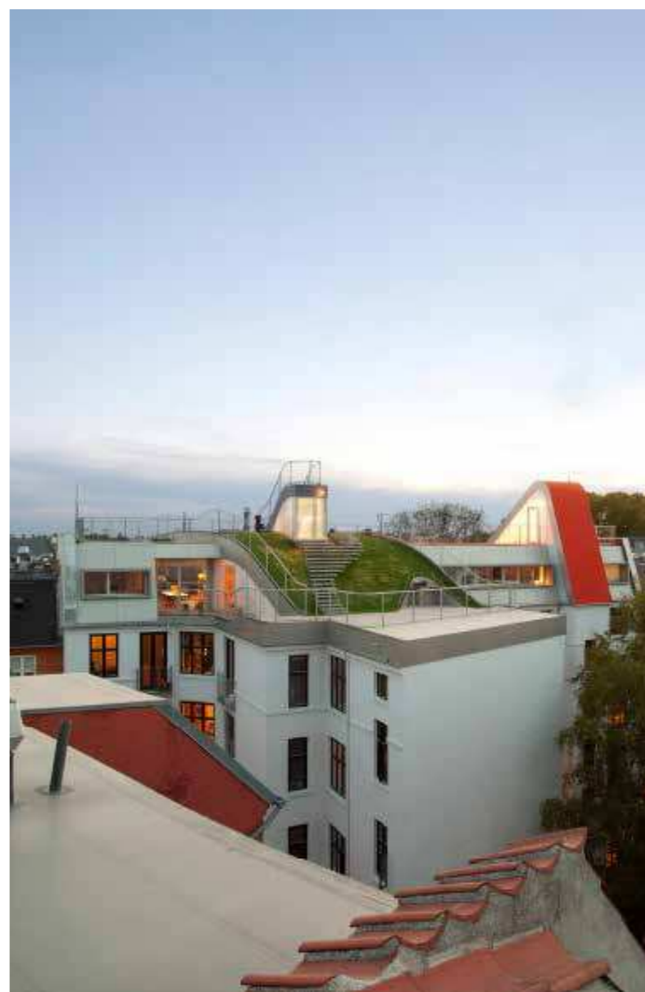
Hvor opholdsarealer på terræn er begrænsede, kan der suppleres med hævede fælles opholdsarealer, indrettet med forskellige kvaliteter og anvendelser.
