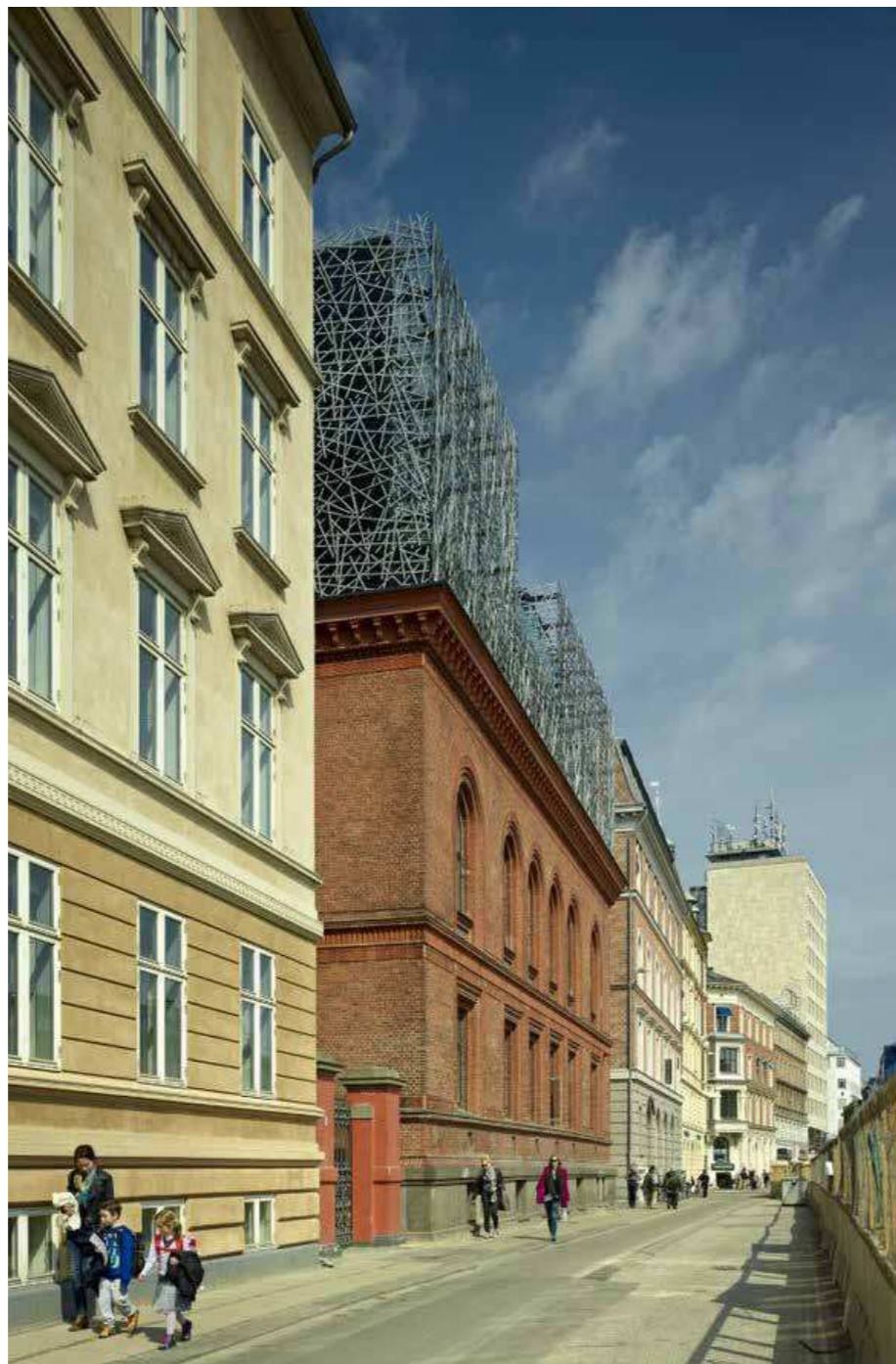
Fritliggende bygning med ny tagetage. Huset er opført med rejst tag, som er fjernet over hovedgesimsen.
