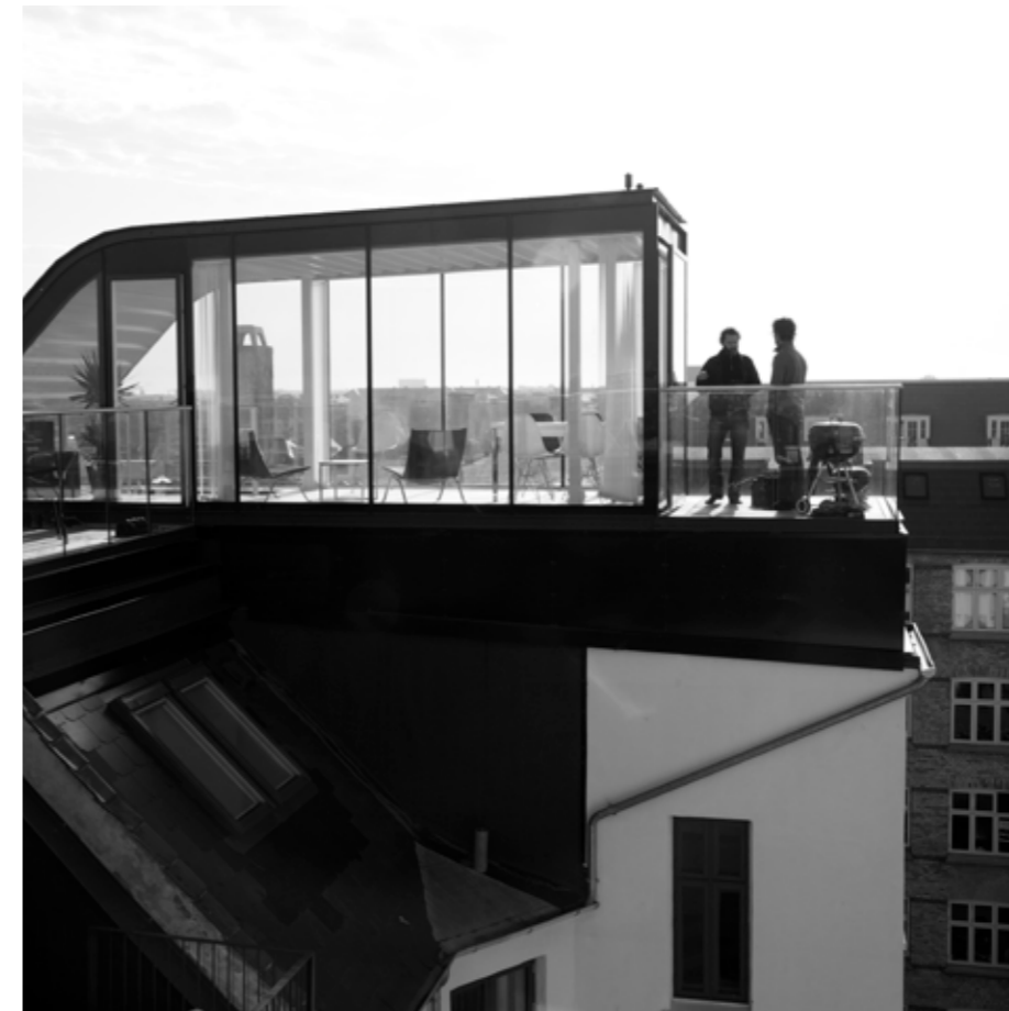
Tagboligerne er tilføjet tagterrasser og penthouses. Materialevalget er tilpasset den eksisterende bygning, hvilket giver et sammenhængende udtryk.
