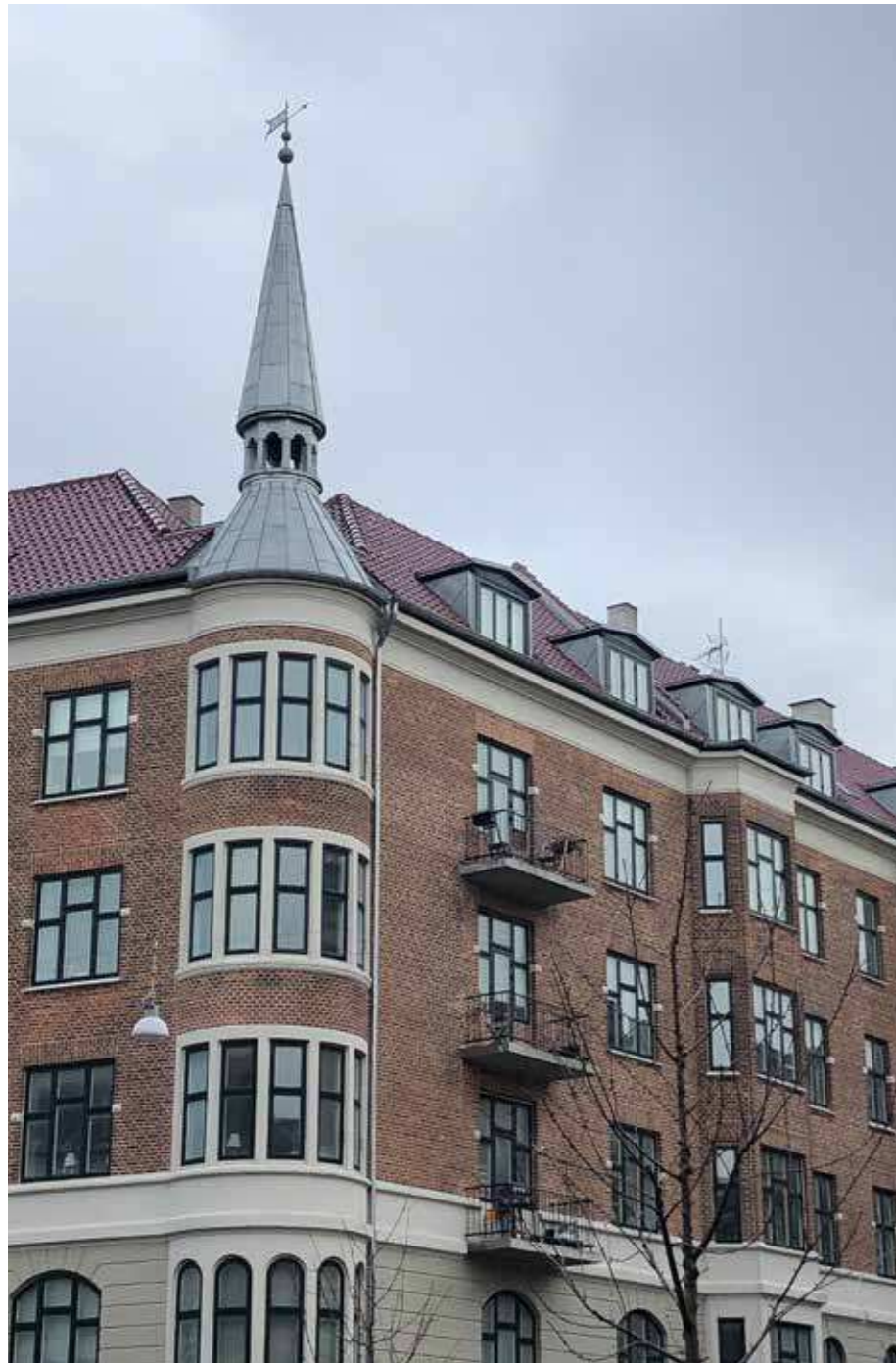
Vellykket tagrenovering på hjørnebygning med tårn.
