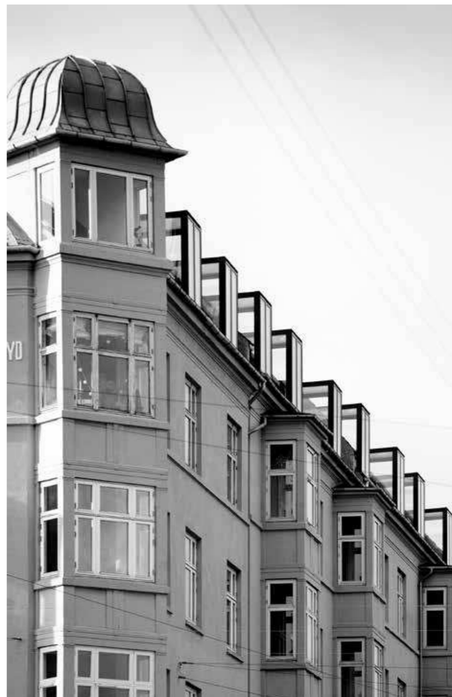
Nye kviste der med sine materialer og udformning er tilføjet som en nyfortolkning af et klassisk bygningselement.
