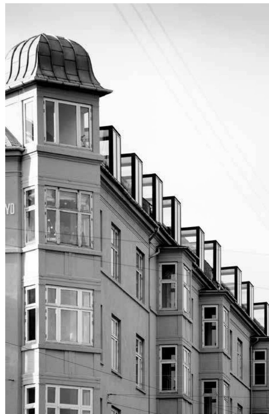
Nye kviste der med sine materialer og udformning er tilføjet som en nyfortolkning af et klassisk bygningselement.
