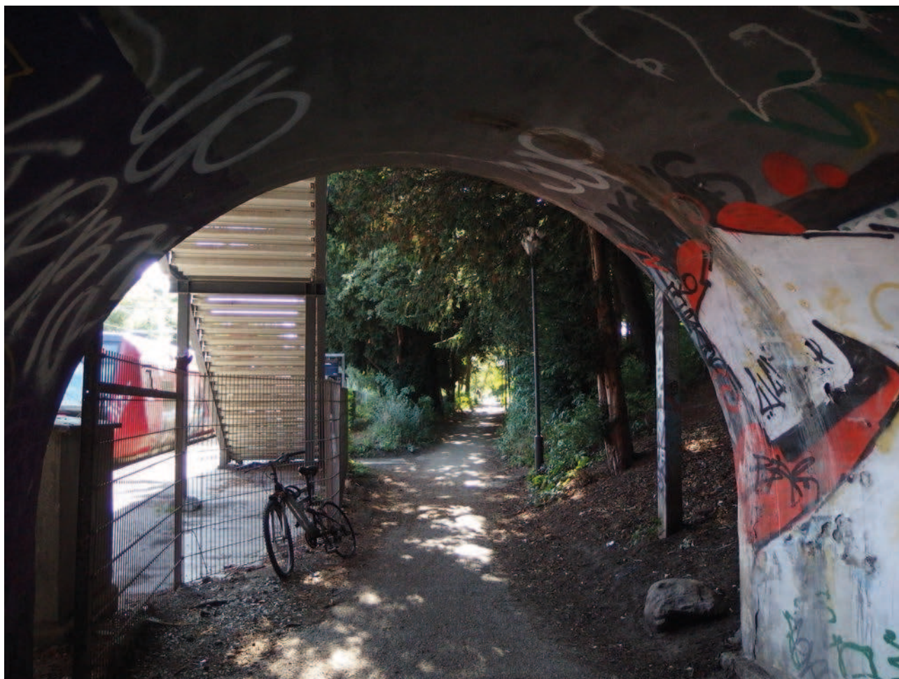
Viadukt under Godthåbsvej, forbinder Skolehaveparken med Hundelufterparken
