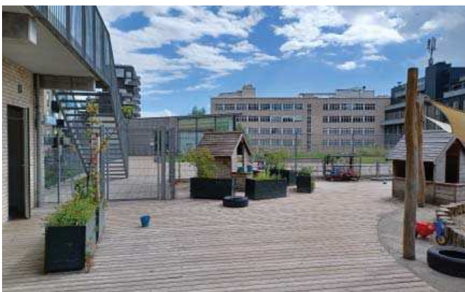
Sandslottet har et stort trædæk langs bygningen.
