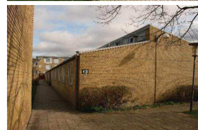
Institutionsbygninger i 1 etage og med forskudte tage
