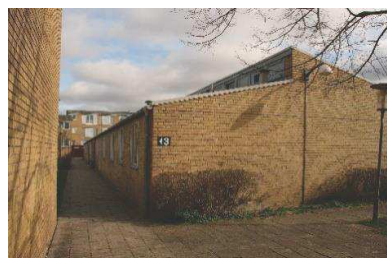
Institutionsbygninger i 1 etage og med forskudte tage
