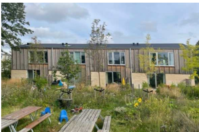
Nye rækkehuse ved Skolesiden set fra syd.
