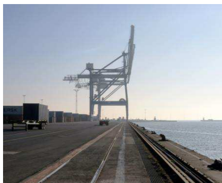
Kranspor og fortøjningspullerter langs den sydlige kajkant.
