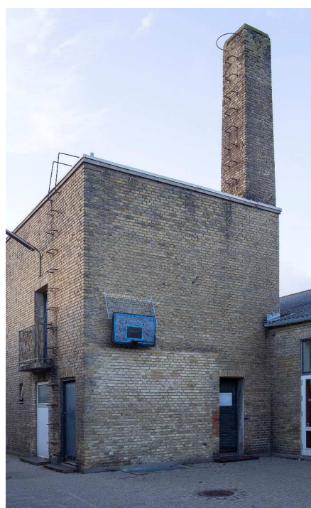
Engvej 143 – Kedelhus opført i 1961.
