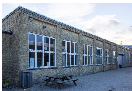
Engvej 145 – Fabriksbygning opført i 1961.
