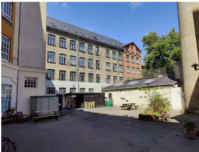
Eksisterende forhold Foto: Københavns Kommune
