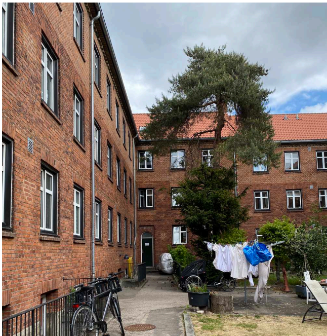
Eksisterende forhold Foto: Københavns Kommune
