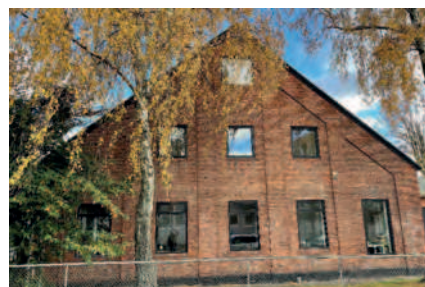
Bedre Byggeskik, Peter Ibsens Allé 24.
