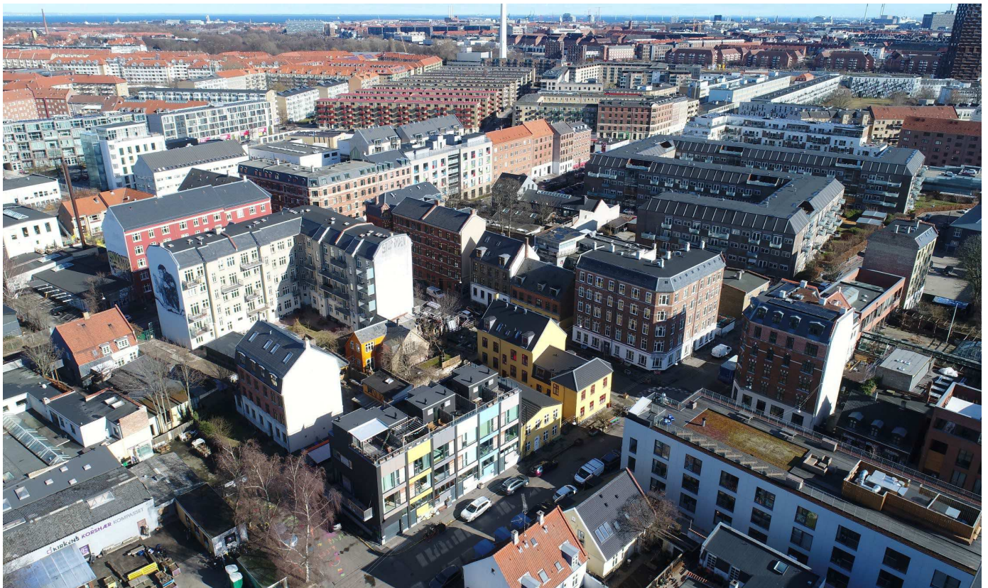
Billede set mod nordøst ved Provstevej og Thoravej. Områdets bygningsmasse varierer i højder, volumen, stilarter og anvendelse.
