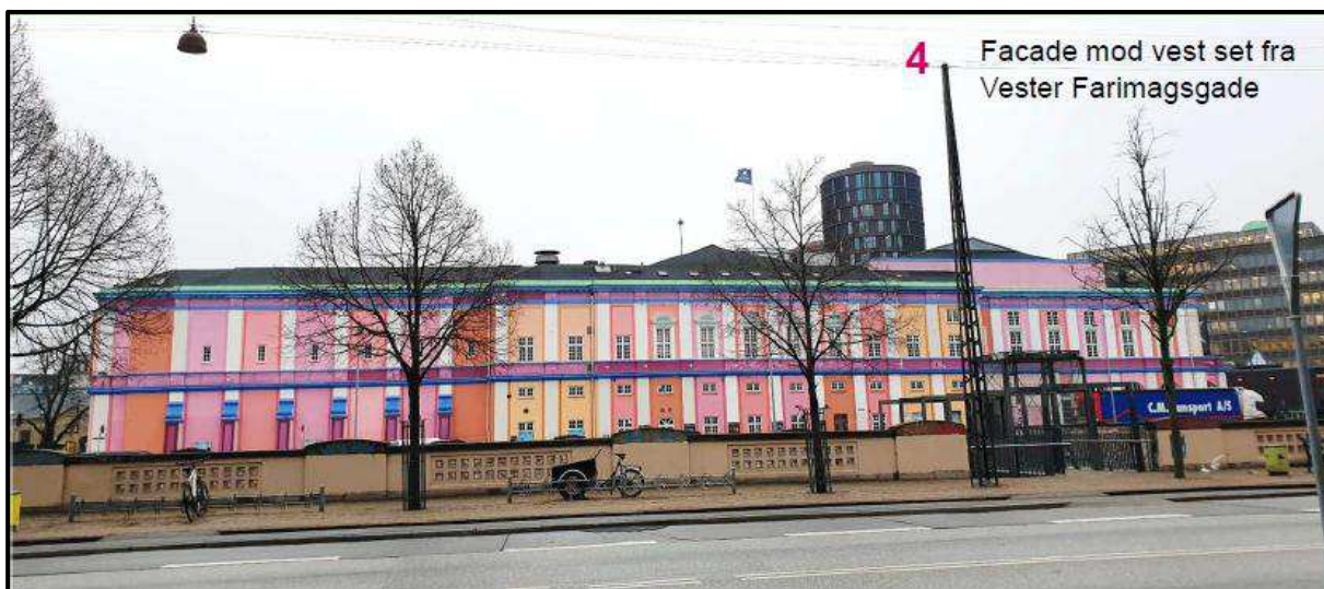
Figur 7.8 Eksisterende forhold, sigtelinje 4, set fra Vester Farimagsgade /4/.
