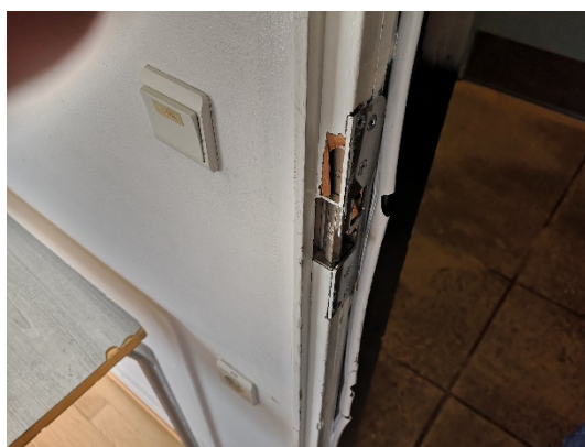
Karm ved dørlås repareres og malerbehandles.
