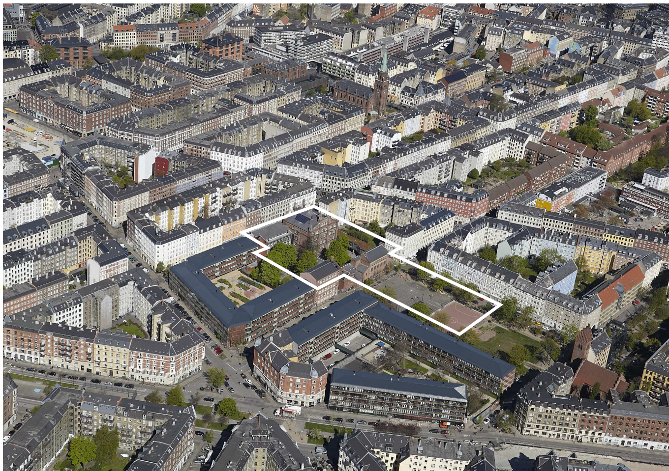
Luftfoto set fra sydøst med markering af lokalplanområdet. Foto: Københavns Kommune
