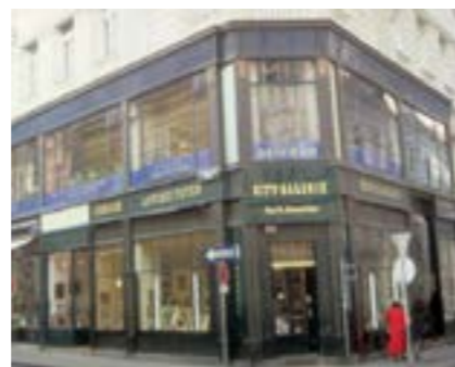
Eksempel på facade, hvor 'basen' har fået et markant andet udtryk end etagerne ovenover.
