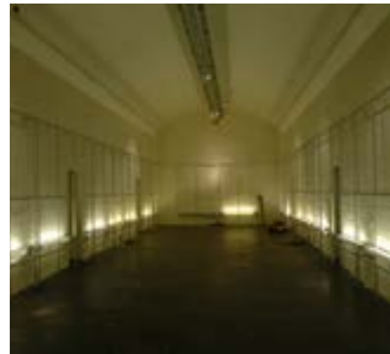
Den eksisterende kælder under pladsen.
