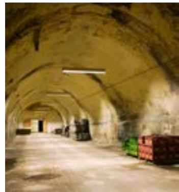
Kælderen under Rød Lagerbygning.
