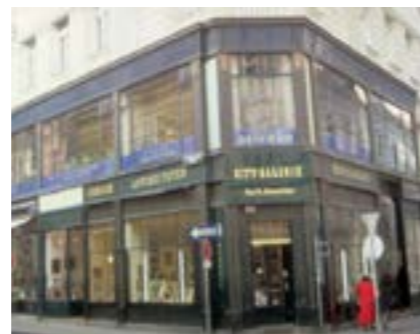
Eksempel på facade, hvor 'basen' har fået et markant andet udtryk end etagerne ovenover.
