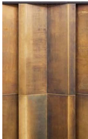
Eksempel på lukket facadeparti i metal: Joseph Pschorr Haus, München. Arkitekt: Kuehn Malvezzi.
