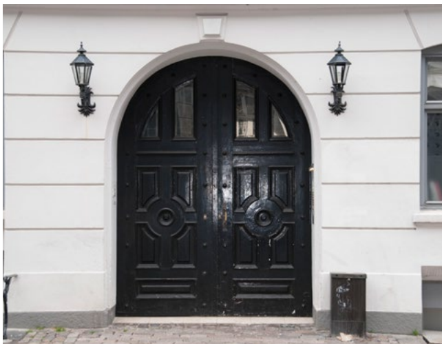
Foto 11. En rundbueport med glasudsmykning i den øverste buede del og markeret med særligt udformet slutsten.
