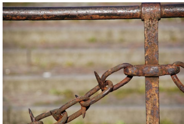
Detalje fra trappeanlægget, hvor udtrykket er mere dramatisk med spidse afslutninger på jernkæden.
