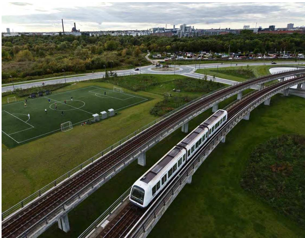
Figur 4.7 Højbanen udføres som en betonkonstruktion på piller ligesom metrohøjbanerne på Amager. Det viste eksempel er fra Ørestad Nord.
