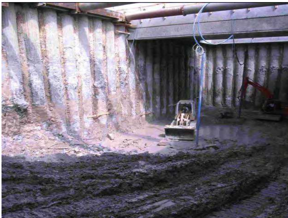
Figur 4.8 Udgravning af stationsboks mellem afstivende vægge udført med sekantpæle i armeret beton, Københavns Metro.
