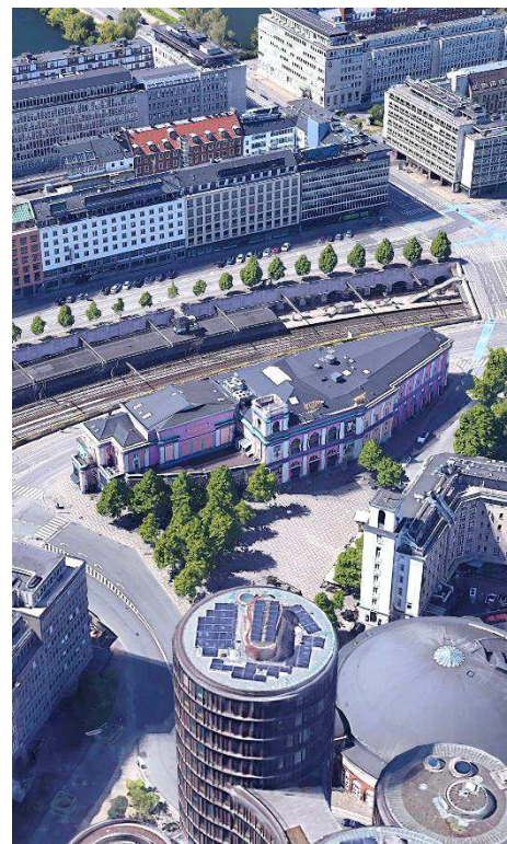
Skråfoto af eksisterende bygning set fra sydøst.
