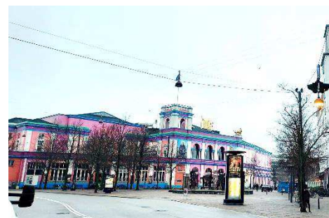
Eksisterende facade mod sydøst. Foto: Cobe
