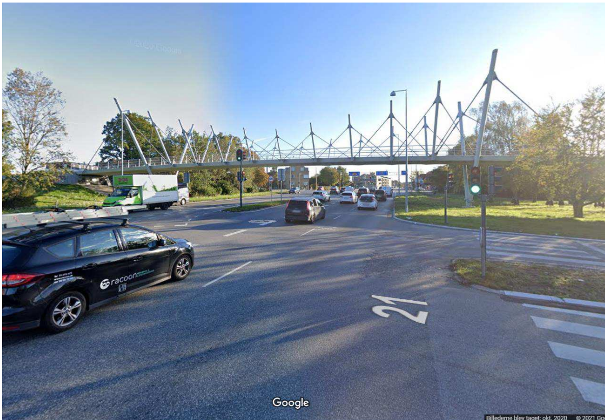
Figur 13-5. Ny sti-bro over Folehaven etableret forår 2020 (Google Streetview).
