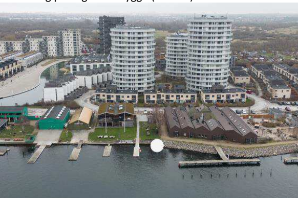
Tilslutning på Islands Brygge (Punkt 9)
