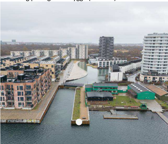
Tilslutning på Islands Brygge (Punkt 8)
