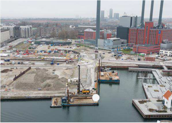
Tilslutning på Enghave Brygge (Punkt I)
