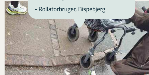
Manglende rampe. Bispebjerg.
