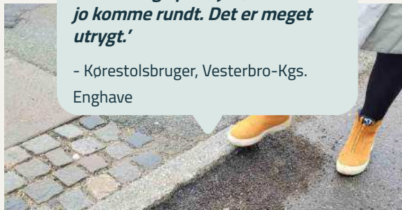
Rampe på Støberigade, Vesterbro-Kgs. Enghave.
