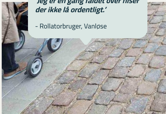
Brostensbelægning uden kørelinjer, Vanløse.
