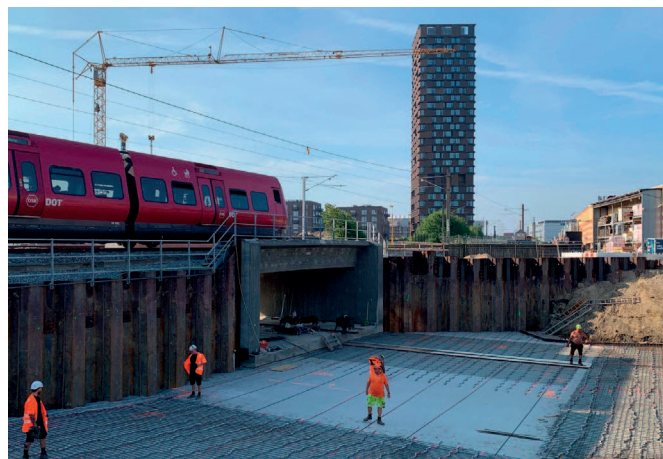
Anlægsarbejde omkring Nordvestpassagen.
