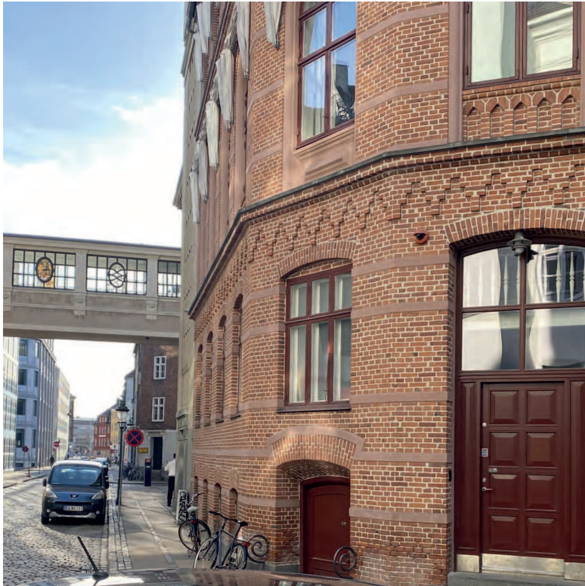
Fotoregistrering Eksisterende forhold
