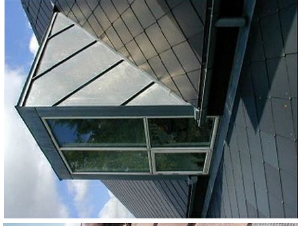
KVISTINDÆKNING - traditionel Zinkoxidbelegning
