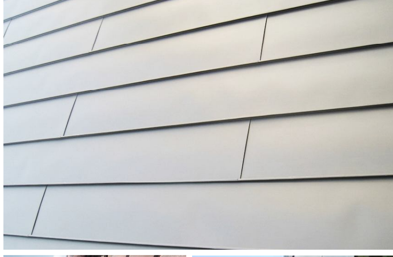
KVISTINDDÆKNING - traditionel zinkinddækning som mod gaden.
