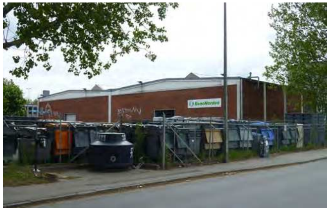
Bygningen set fra Raffinaderivej
