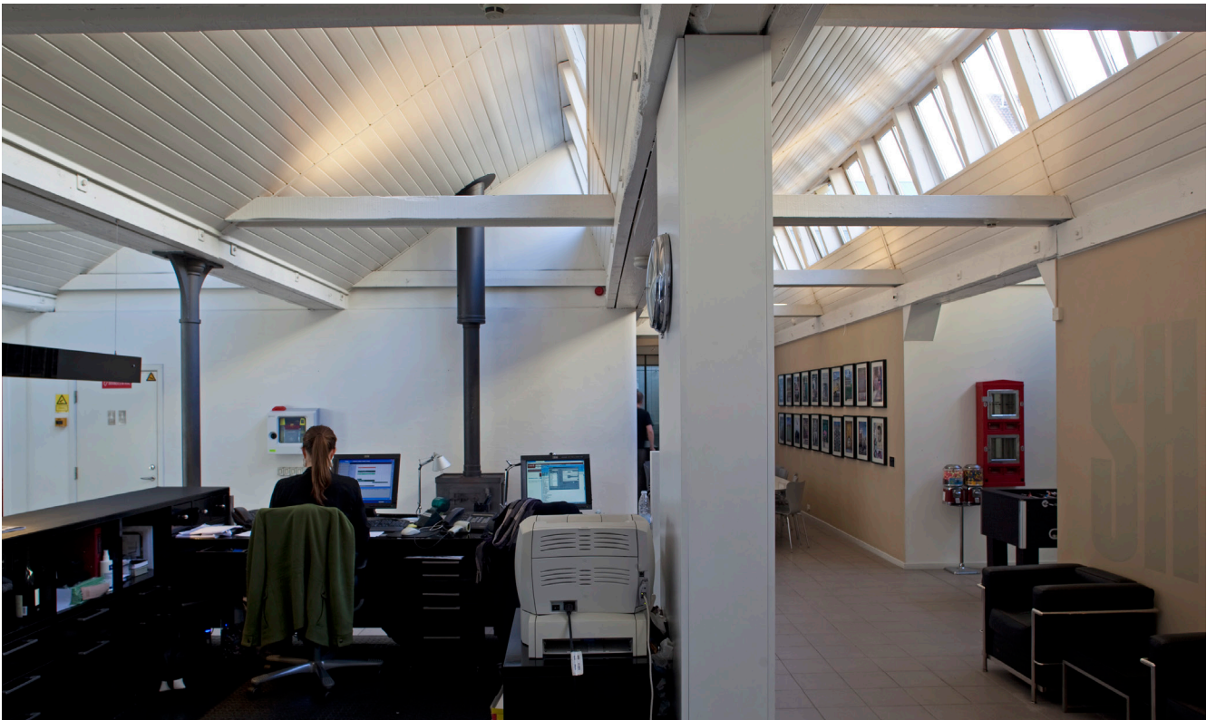
Indretning af kontorer i tidligere fabriksbygninger med shedtag.
