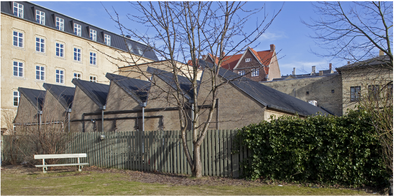
De tidligere farveribygninger
