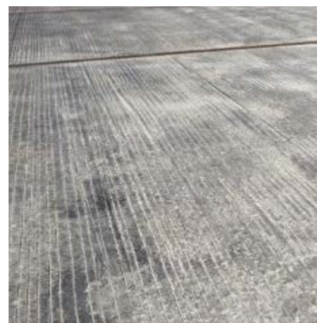
Grov beton på terrasse
