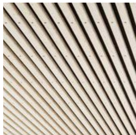
Loft udført som trælisteloft
