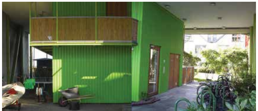
Bred port, der giver kig til gården og er indrettet med hverdagsfunktioner. Reference: Malmø.
