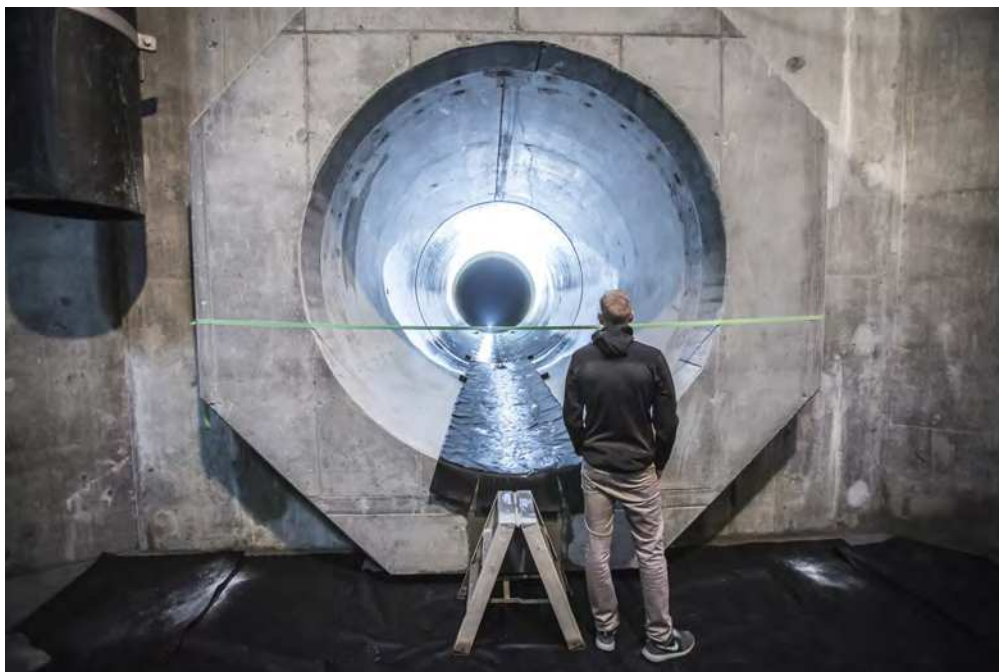
Østerbro skybrudstunnel. Foto: HOFOR
