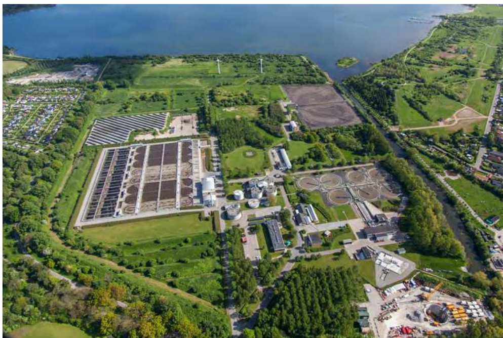
Renseanlæg Damshusåen. Foto: Hviid Photography
