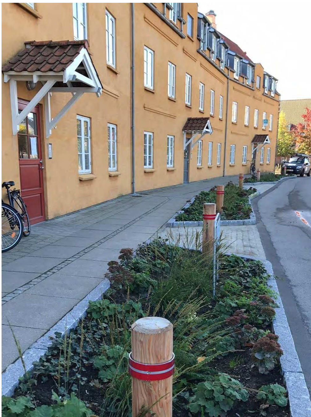
Vejbed til forsinkelse og nedsvivning af regnvand på Erik Ballings Vej. Foto: Louise Madsen
