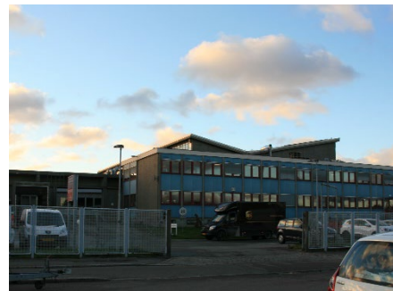
Den vestlige side af Bådehavnsgade er i dag præget af store erhvervsbygninger. Foto: Københavns Kommune, november 2018
