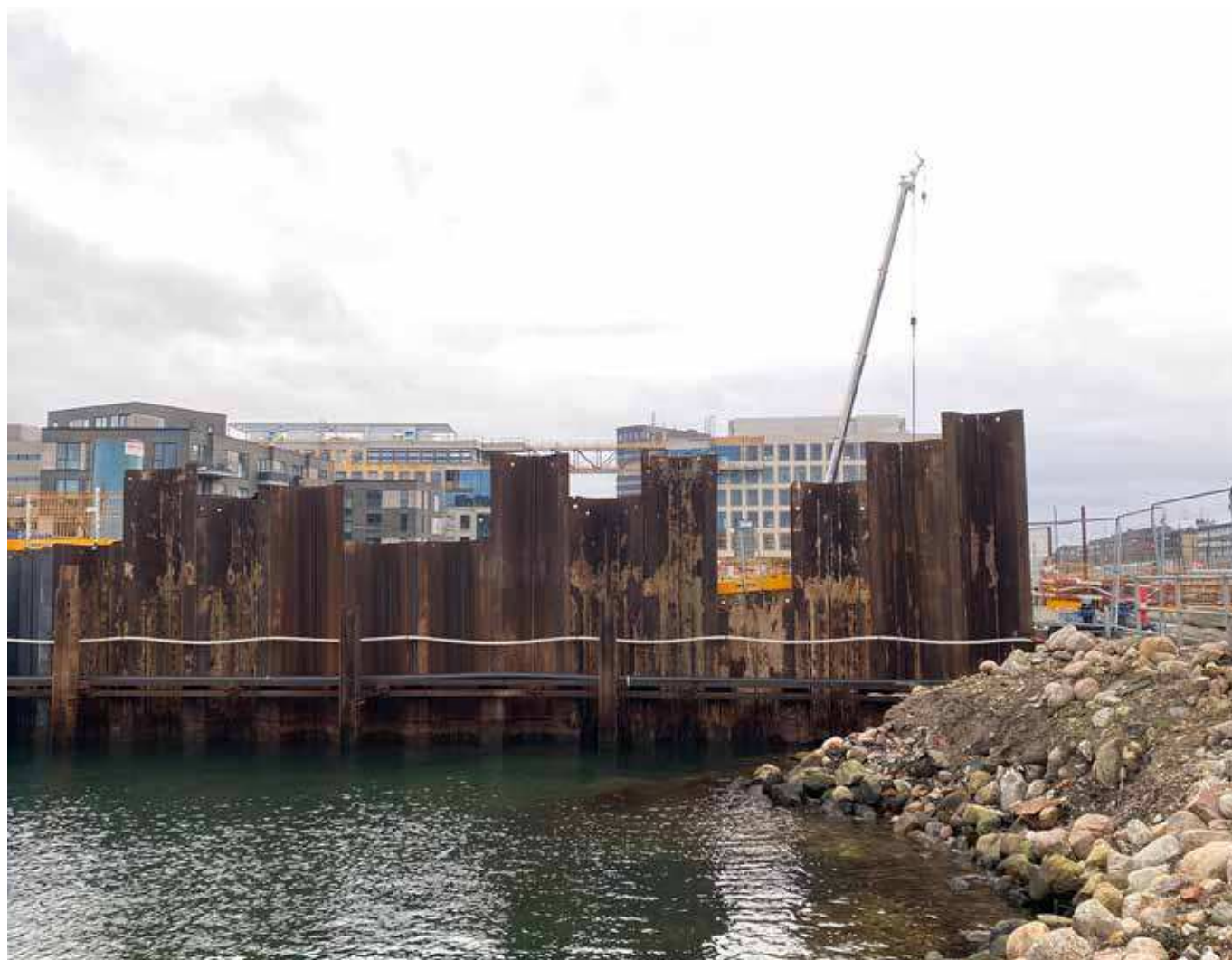
Byggeri ved Sandkaj i Nordhavn
