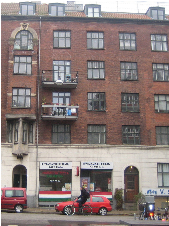
Facade mod Dybbølsgade
