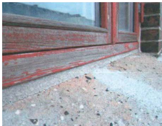
Vindue med sælbænk på gadefacade
