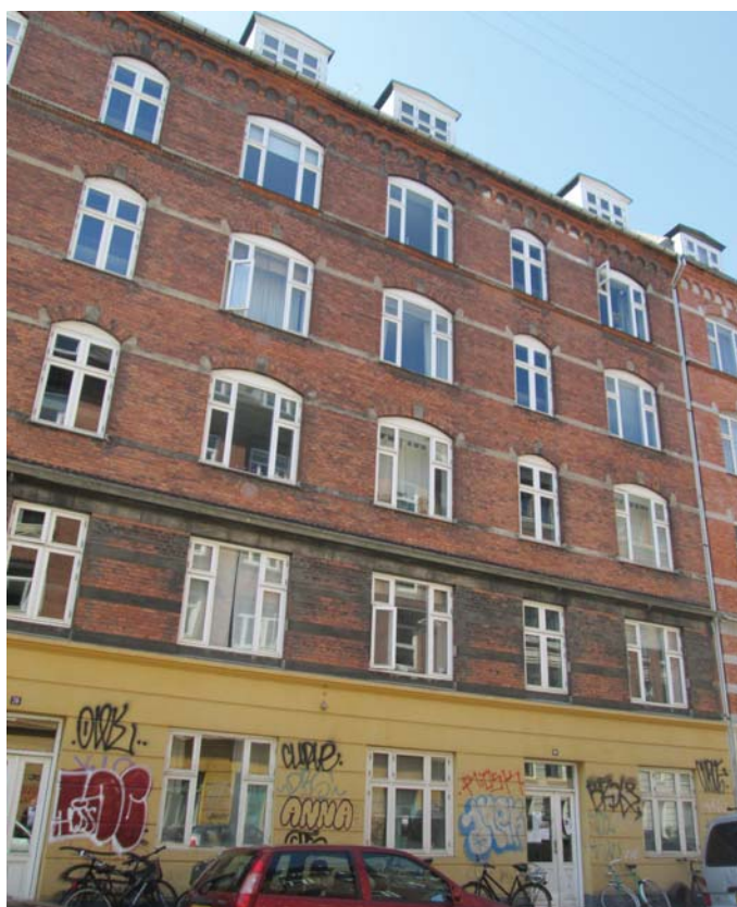
Facade mod Valdemarsgade
