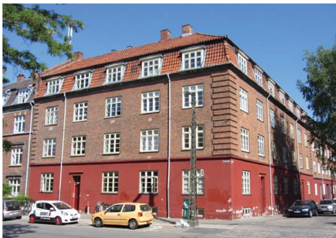
Gadefacade Højenhald 12-14 / Svenskelejren 11
