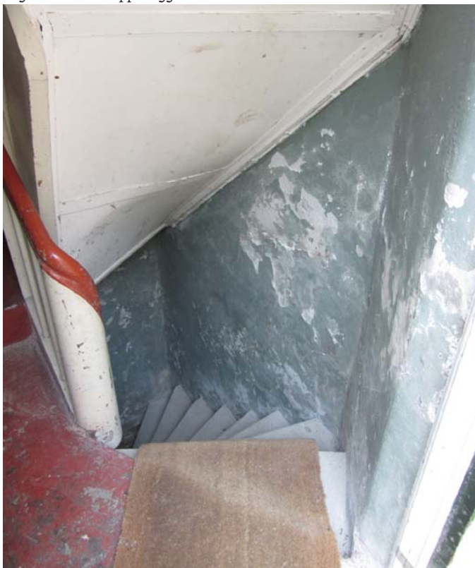
Fugtskadede bitrappevægge
