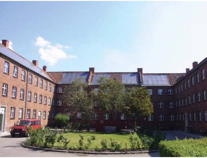
Gårdrum / eksisterende solfangeranlæg
