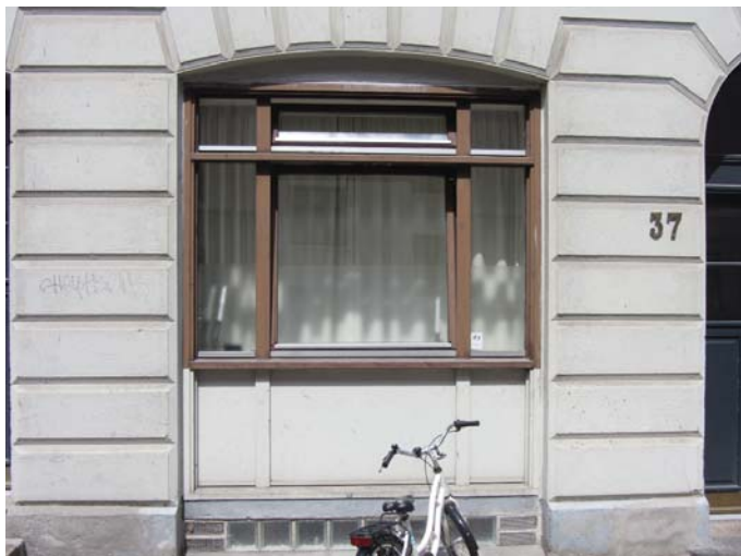
Tidligere butik med uisoleret brystning
