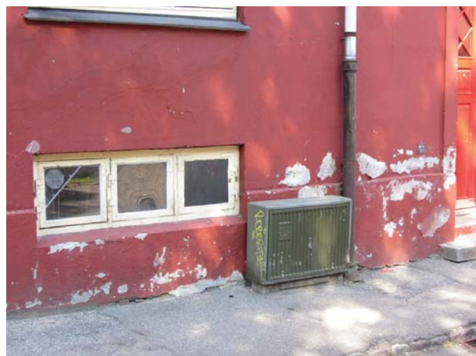
Afskallet sokkelpuds på gadefacade
