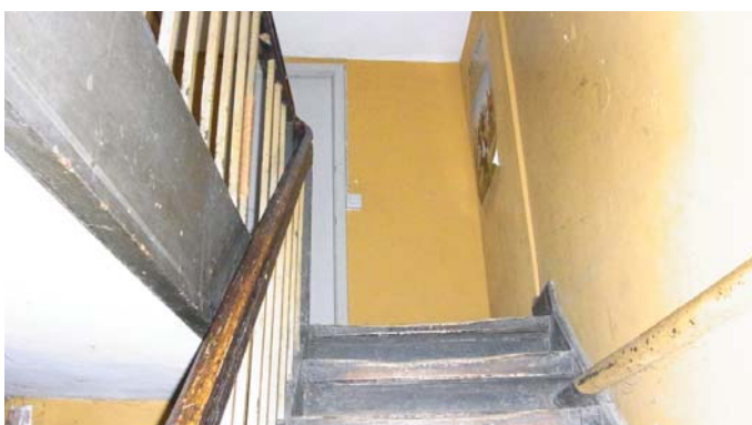
Trappeopgang med ligeløbstrappe
