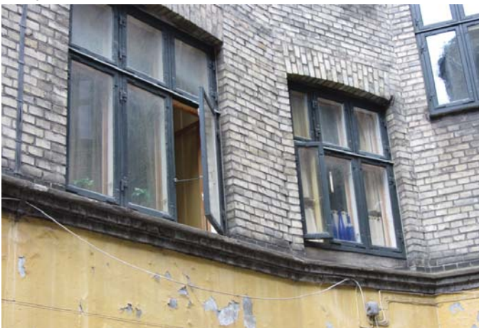
Udsnit af tagetage mod gaden Gårdfacade med nedslidte vinduer
