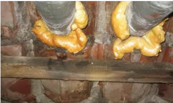
Tagfet tidligere tætnet med skum med stort varmetab
