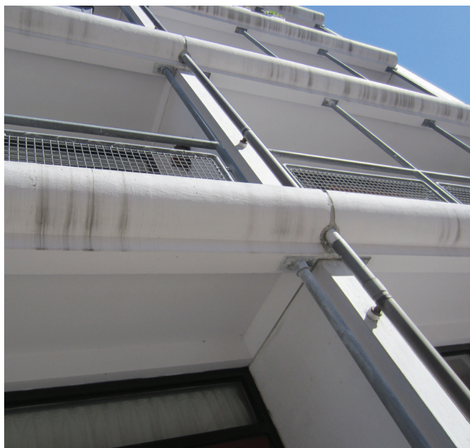
Vinduer udskiftes og energioptimeres og kuldebroer fjernes
