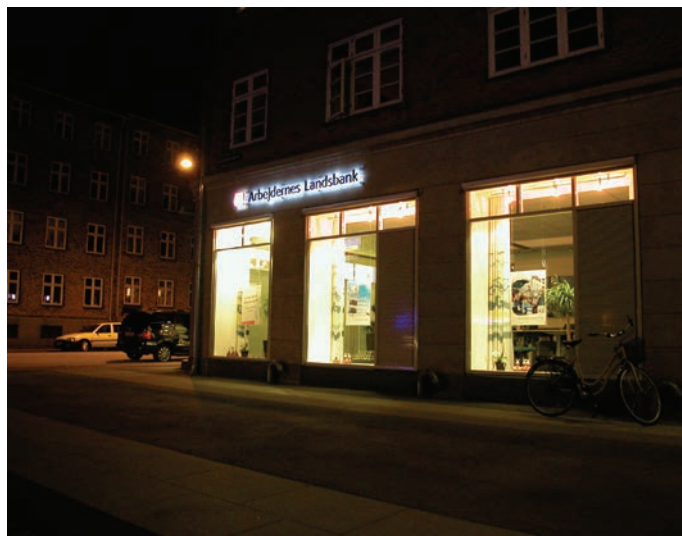
Skiltebelysning med coronaeffekt (bogstaver, der er belyst bagfra) løser på fin måde eventuelle blændingsproblemer.
