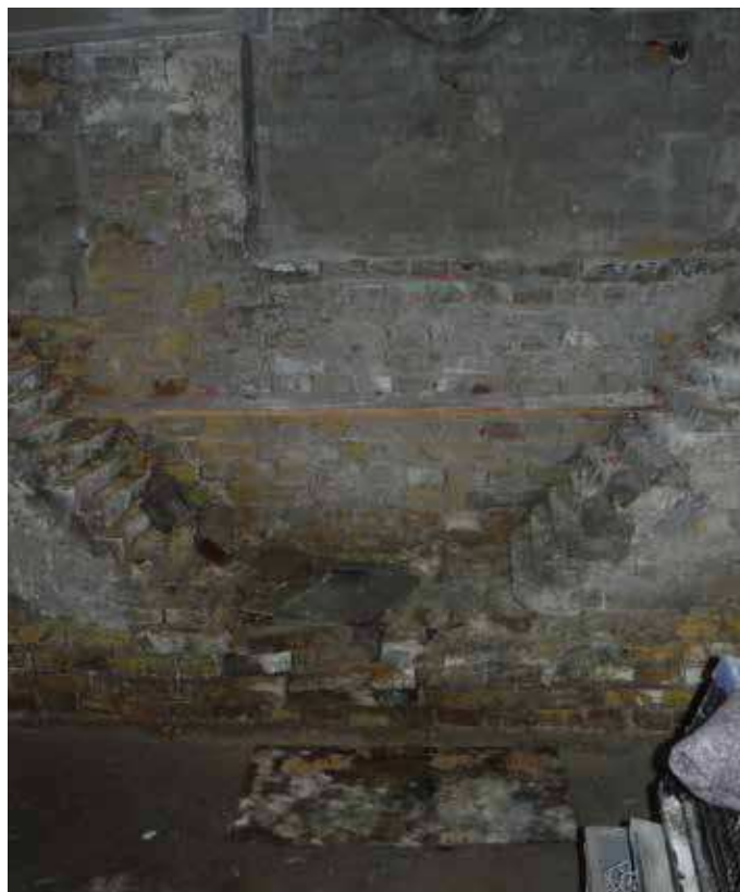
Der fugt- og klimasikres og isoleres
