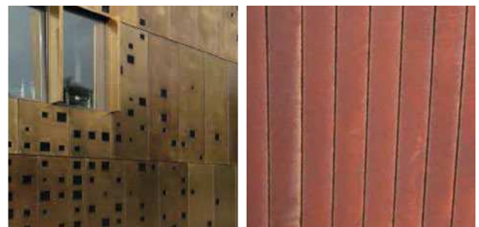
Facaden får et relief af lys og skygge, da etageadskillelsen er glat, mens de etagehøje vinklede elementer er profilerede. Ill. Arkitema.
